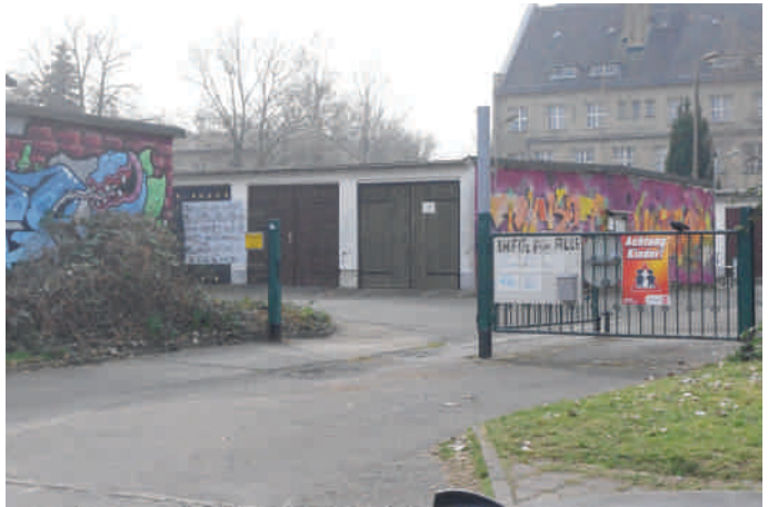
Der Garagenhof Krönerstraße.
