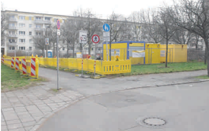
Fernwärmeausbau in Anger-Crottendorf
