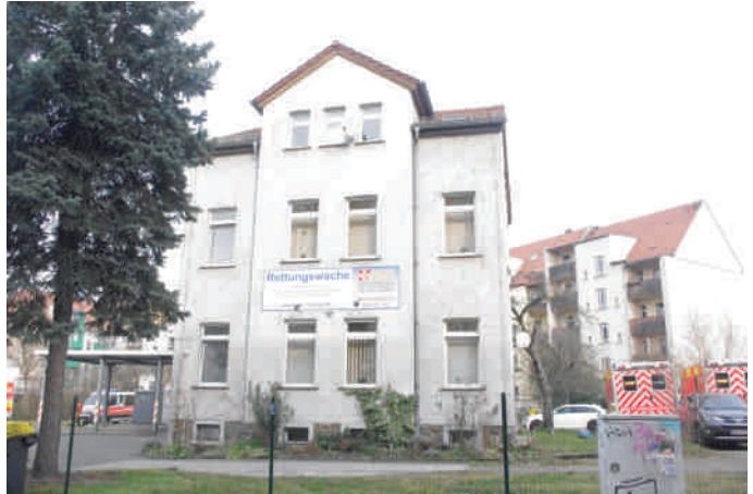
Die Rettungswache in der Theodor-Neubauer-Straße, Unterbringung in einem Wohnhaus.
