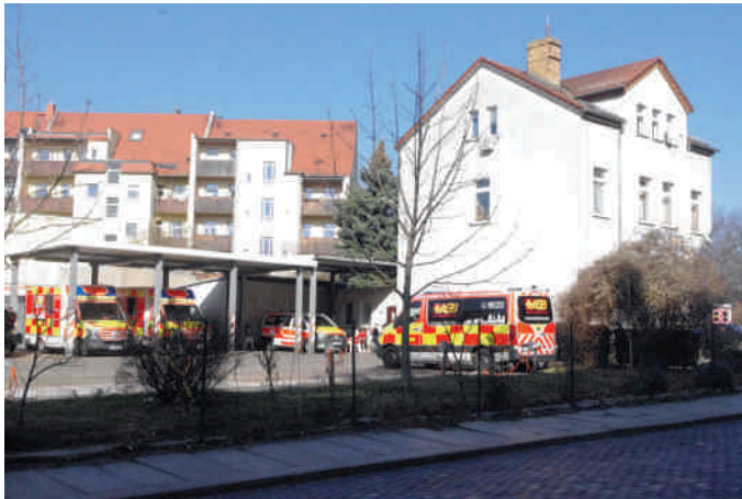
Die Rettungswache in der Theodor-Neubauer-Straße entspricht nicht den aktuellen Standards.
