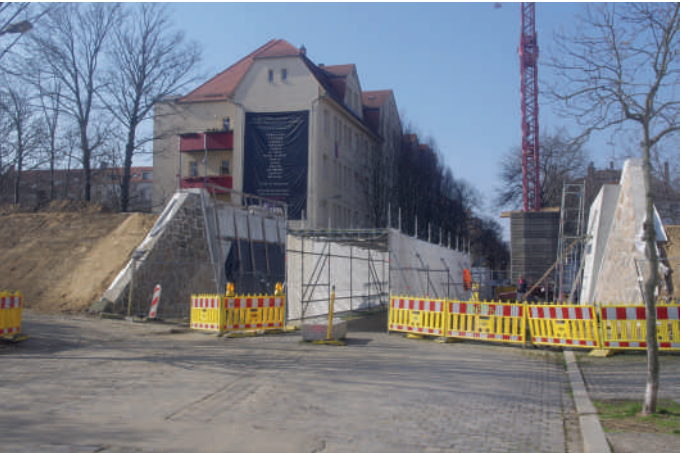
Der Brückenneubau über die Eisenbahnstraße geht voran.
