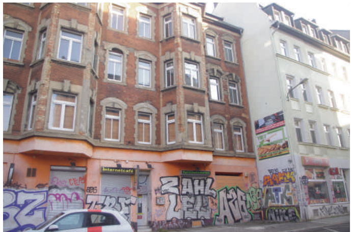
Zweinaundorfer Straße 13, zugemauert bis in die erste Etage.
