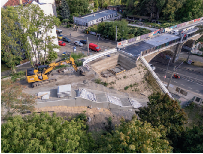
Drohnenaufnahme der Bauarbeiten am Viadukt an der Wurzner Straße im September 2025.
