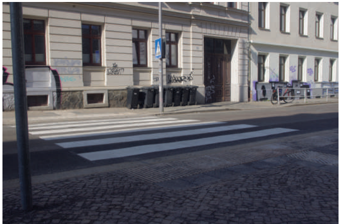
Der umgebaute Fußgängerüberweg in der Martinstraße vor der Ernst-Pinkert-Grundschule. Eine Gehwegvorstreckung verkürzt den Weg über die Straße.
