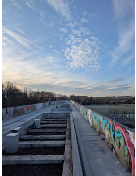
Pflanztröge für Bäume auf dem Viadukt.
