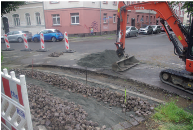
Baustelle im Mai. Rund um den Konsum entstanden viele Bordabsenkungen, die das Gehen zu Fuß und das Queren der Straße erleichtern.
