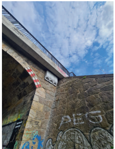
Fledermauskästen an der Parkbogen-Brücke über die Liselote-Herrmann-Straße.
