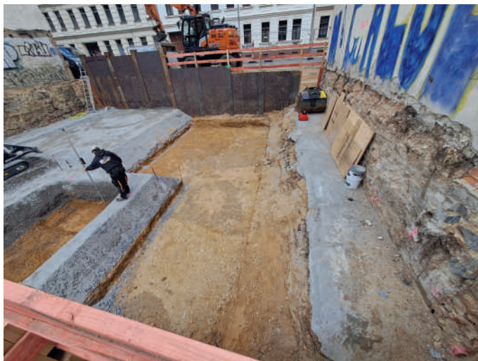
Blick in die Baugrube des Neubaus in der Mierendorffstraße.
