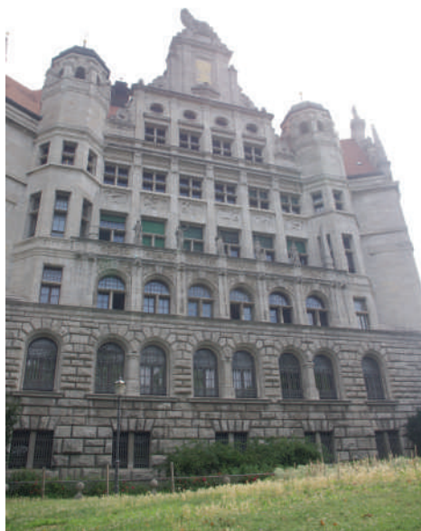
Im Angebot: Büroarbeitsplatz im 2. OG mit großzügigem Balkon in sonniger Südwest-Lage.
