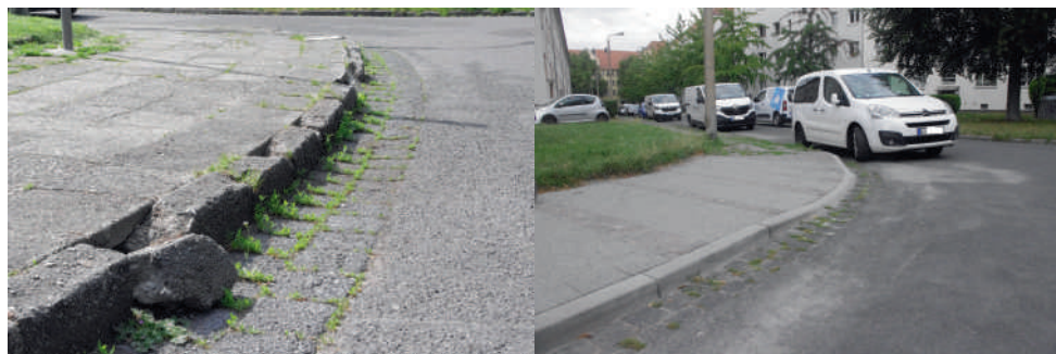
Gehweg an der Ecke Kröner-/ Segerstraße vor (li.) und nach den Bauarbeiten. Jetzt muss nur noch klar sein, dass man abgesenkte Borde nicht zaparkt oder Mülltonnen davor stellt.
