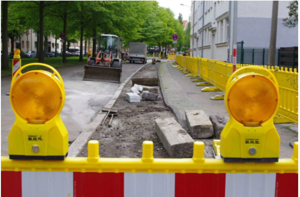
Straßenausbesserungsmaßnahmen in der Gregor-Fuchs-Straße
