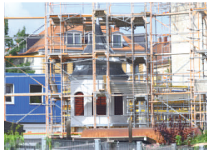
Einer von zwei Türmen für das Dach der alten Hermann-Liebmann-Schule
