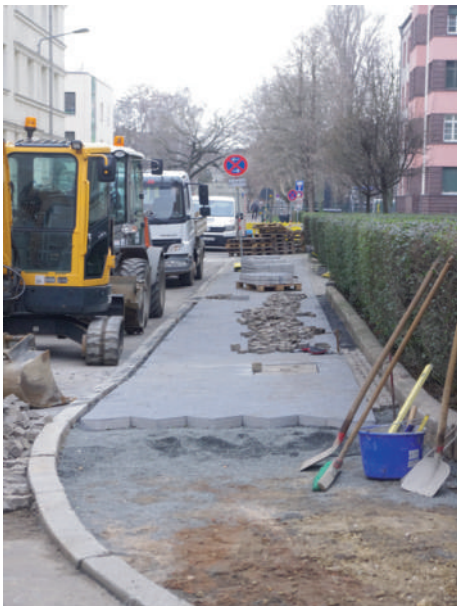
Gehwegsanierung in der Stünzer Straße
