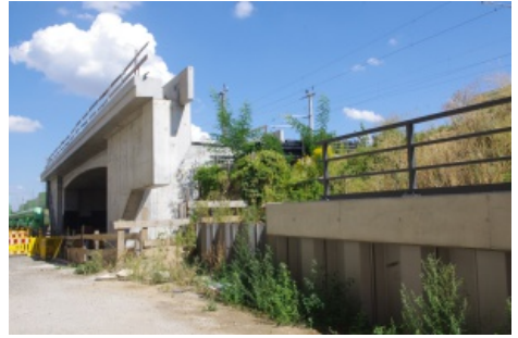
Wird ab September in die richtige Position eingeschoben: Die westliche Neubaubrücke über die Cunnnersdorfer Straße
