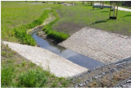
Ablassbauwerk am nordwestlichen Ende der Retentionsfläche
