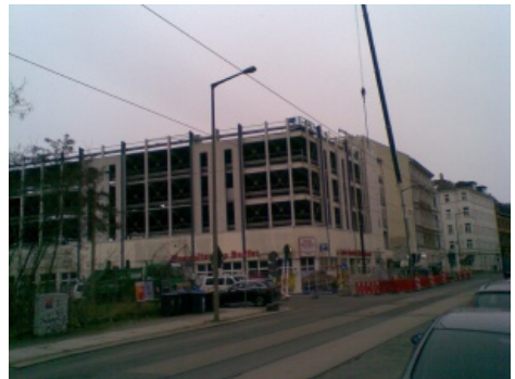
Abrissarbeiten am Parkhaus Kohlgarten-, Berstraße am 1. April
