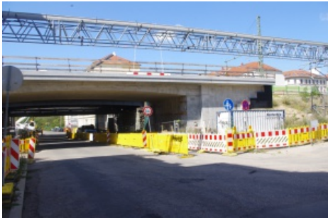
Brücken über die Zweenfurther Straße: östliche Neubaubrücke (Vordergrund), dahinter altes Brückenbauwerk, dahinter Behelfsbrücke, dann westliche Neubaubrücke
