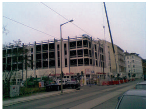
Abbrissarbeiten am Stahlskelett-Parkhaus Kohlgarten-, Ecke Bergstraße am 1. April 2022.
