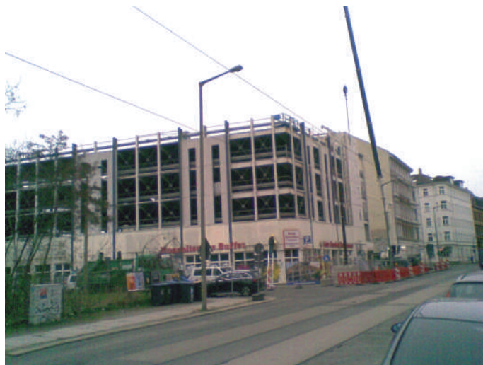
Parkhaus Bergstraße während des Rückbaus im April 2022
