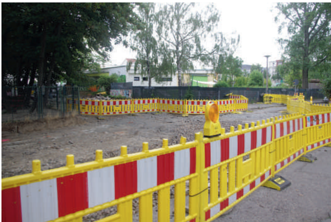
Stünzer Straße zwischen Kita „Dschungelbande“ und 74. Grundschule während des Umbaus.
