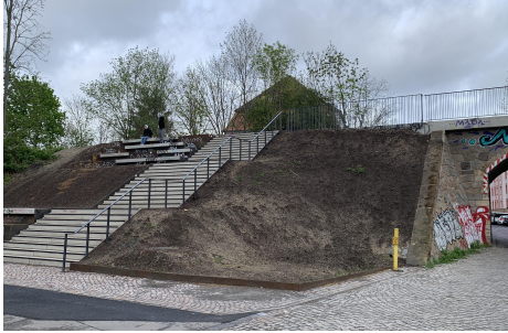
Neue Treppenanlage an der Brücke Theodor-Neubauer-Straße
